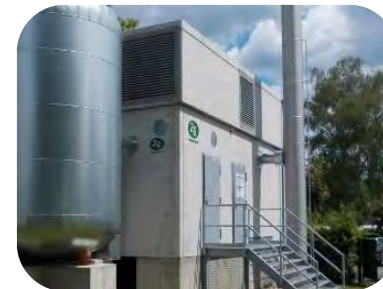
Zubehör: Absorptions- kältemaschine Dampferzeuger Pufferspeicher Transformator
