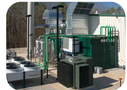
Zubehör: Absorptions- kältemaschine Dampferzeuger Pufferspeicher Transformator
