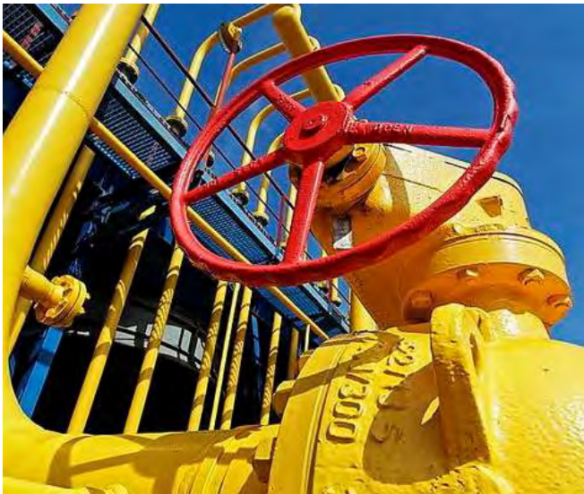
Beimischung ins bestehende Gasnetz
